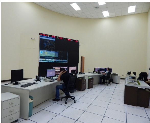
Centro de Operaciones CNDC
