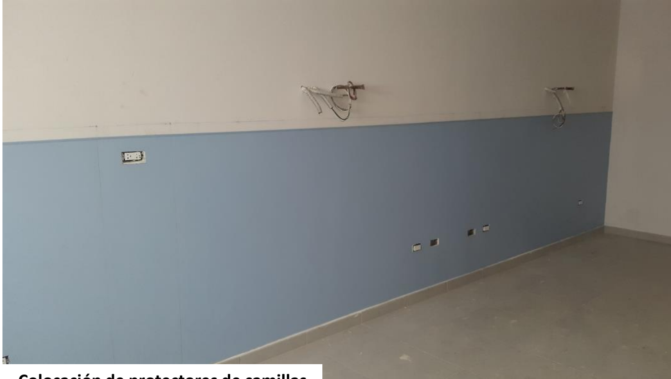
Colocación de protectores de camillas
