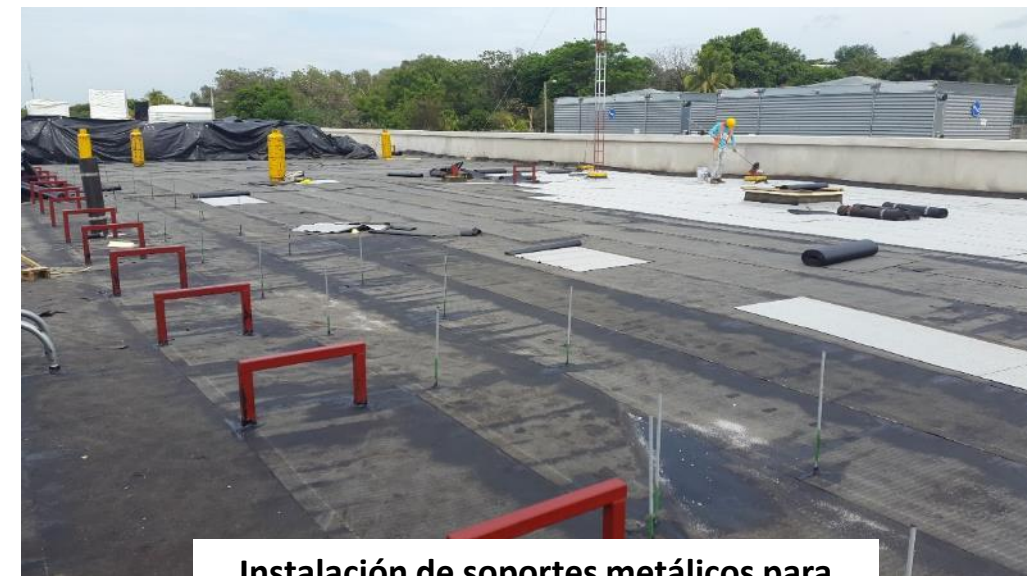
Instalación de soportes metálicos para tuberías de agua caliente
