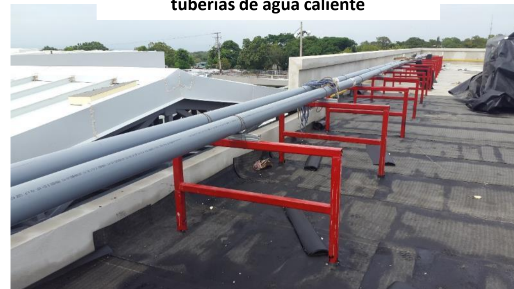
Instalación de soportes metálicos para tuberías de agua caliente
