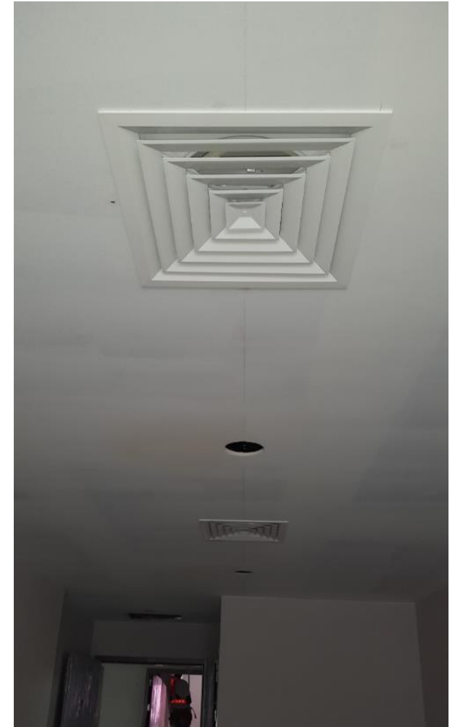
Colocación de rejillas de aire acondicionado
