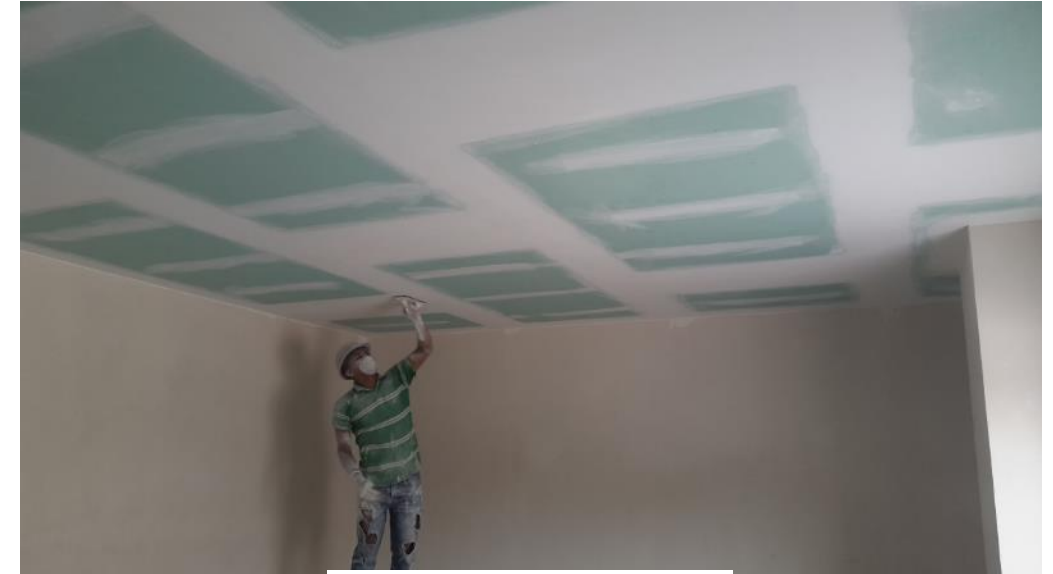
Lijado en cielos falsos
