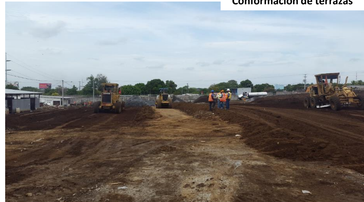
Conformación de terrazas
