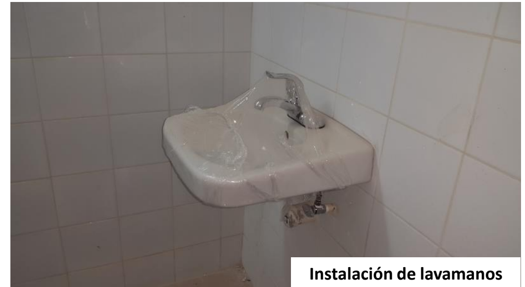
Instalación de muebles
