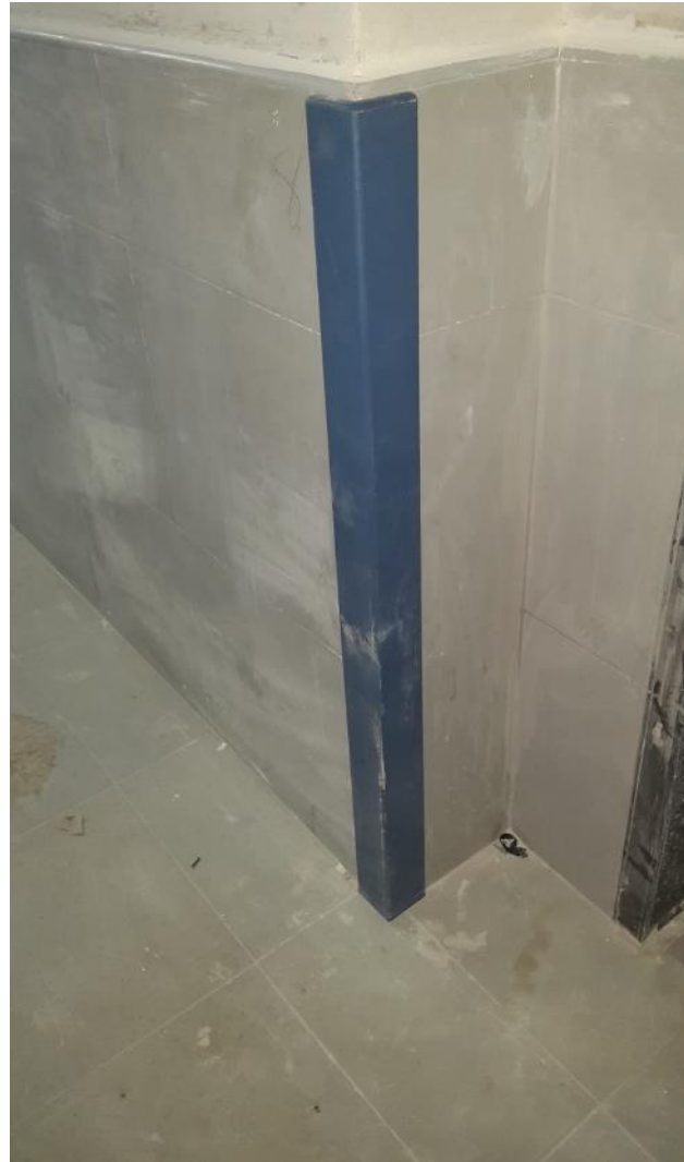
Colocación de protectores esquineros
