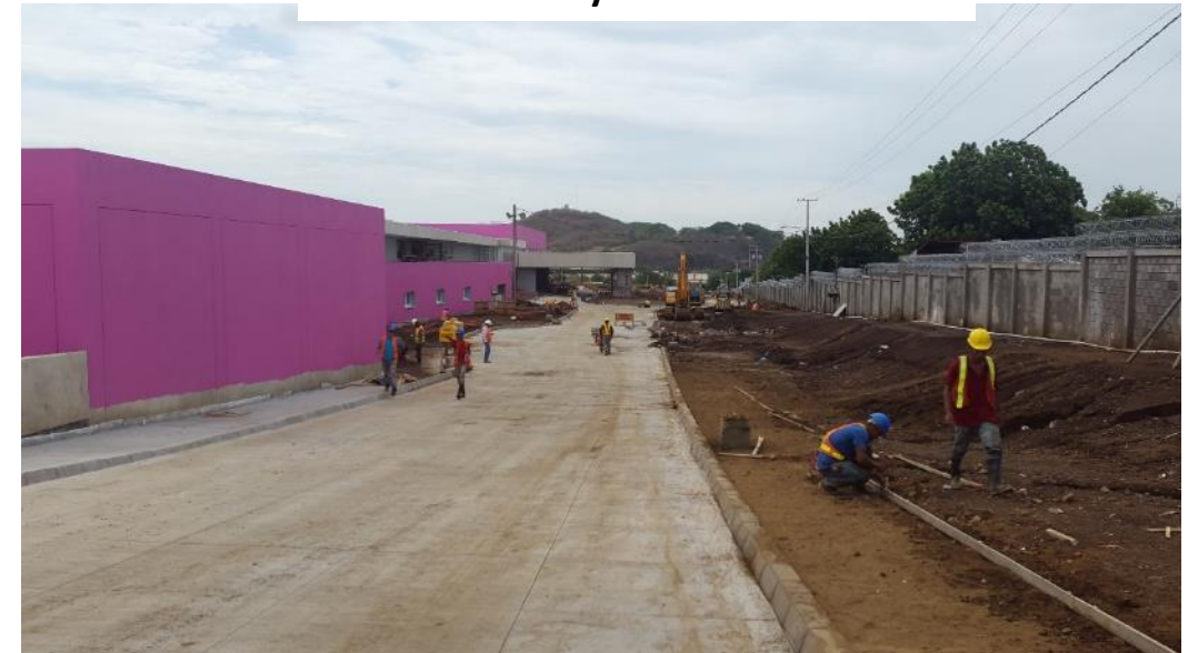
Conformación y colado de andenes
