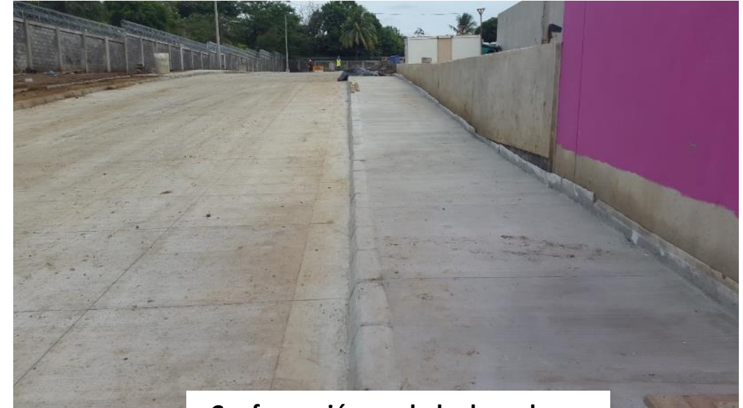
Conformación y colado de andenes
