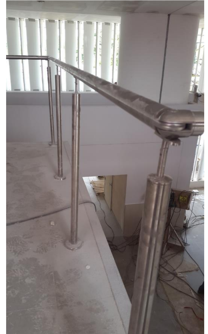
Colocación de barandales y pasamanos
