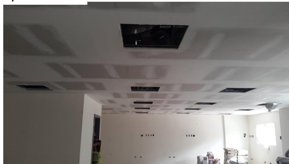
Pintura en paredes y cielos falsos
