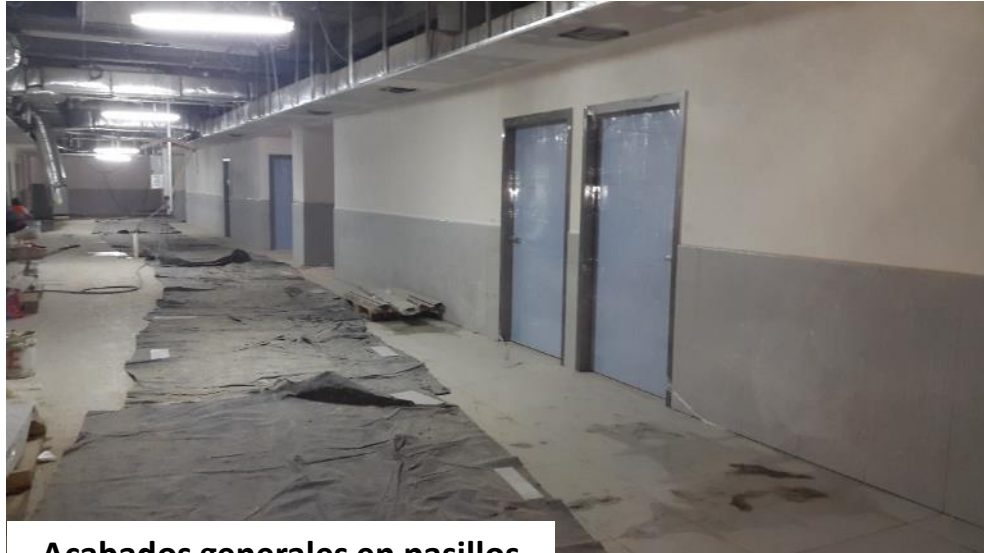
Acabados generales en pasillos
