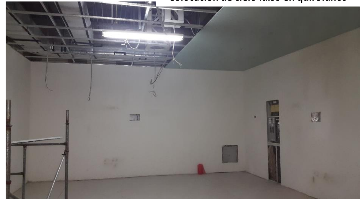
Colocación de cielo falso en quirófanos
