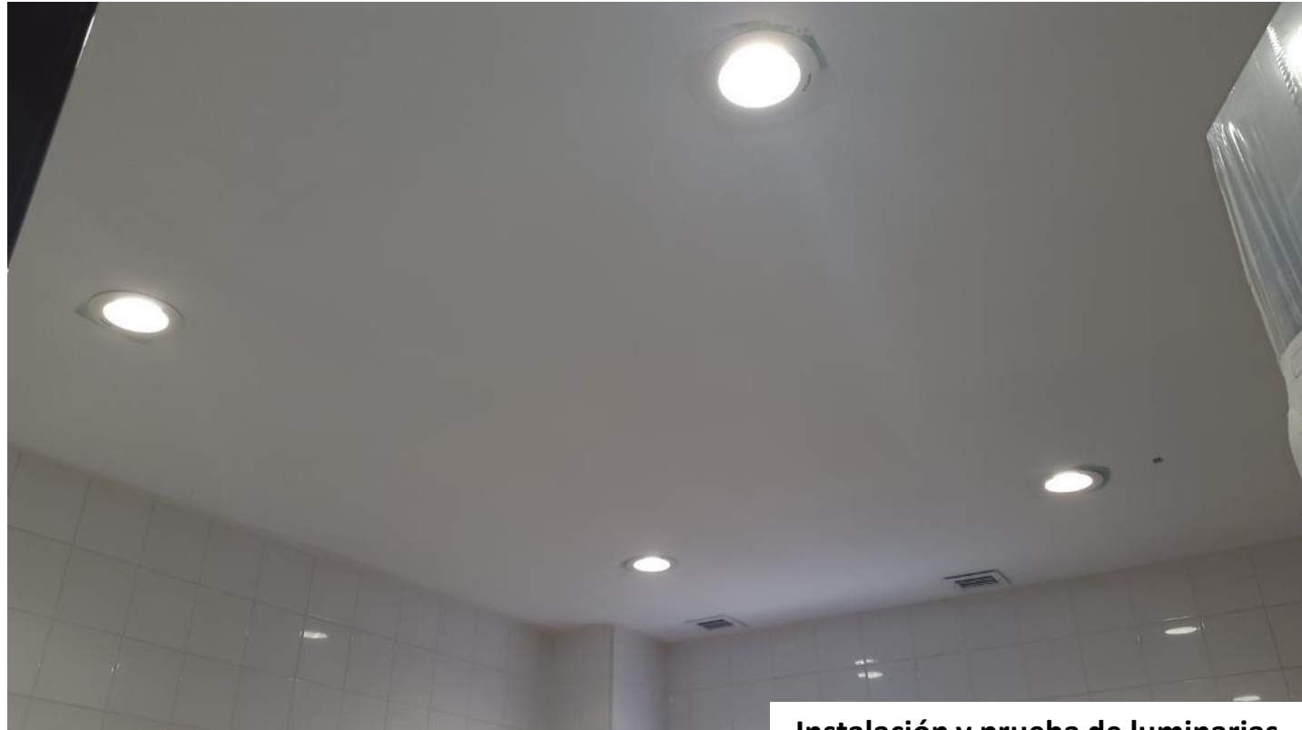
Instalación y prueba de luminarias
