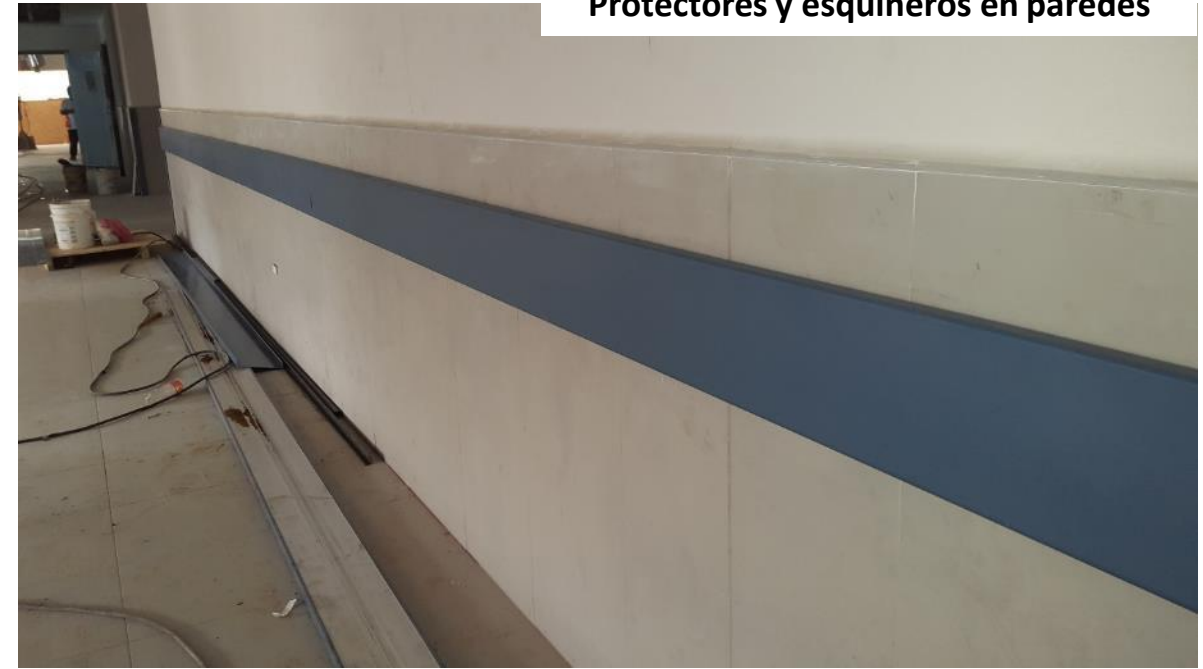
Protectores y esquineros en paredes
