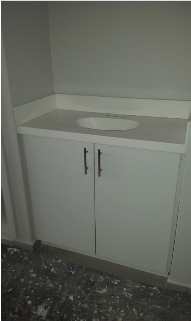
Instalación de muebles en habitaciones
