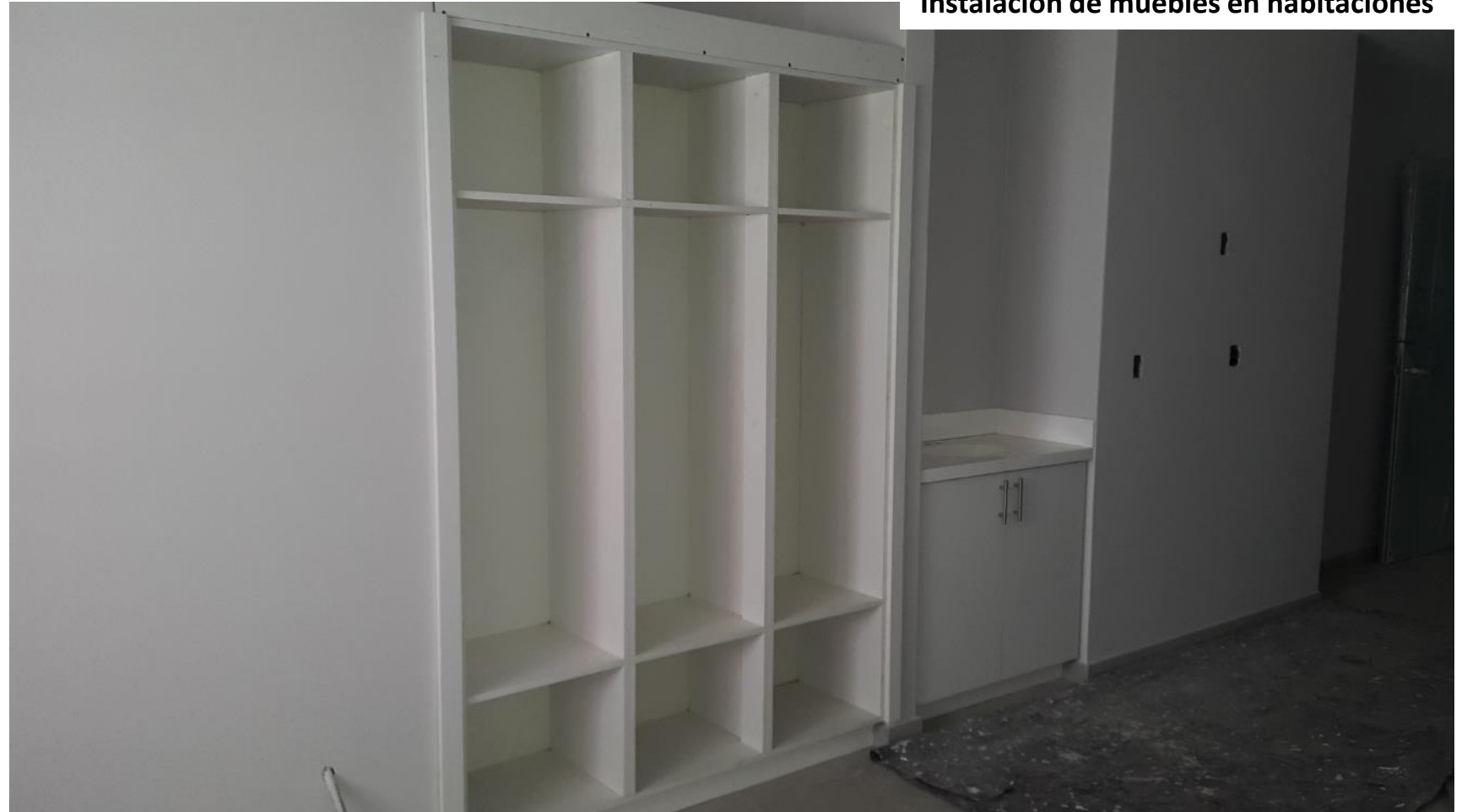
Instalación de muebles en habitaciones
