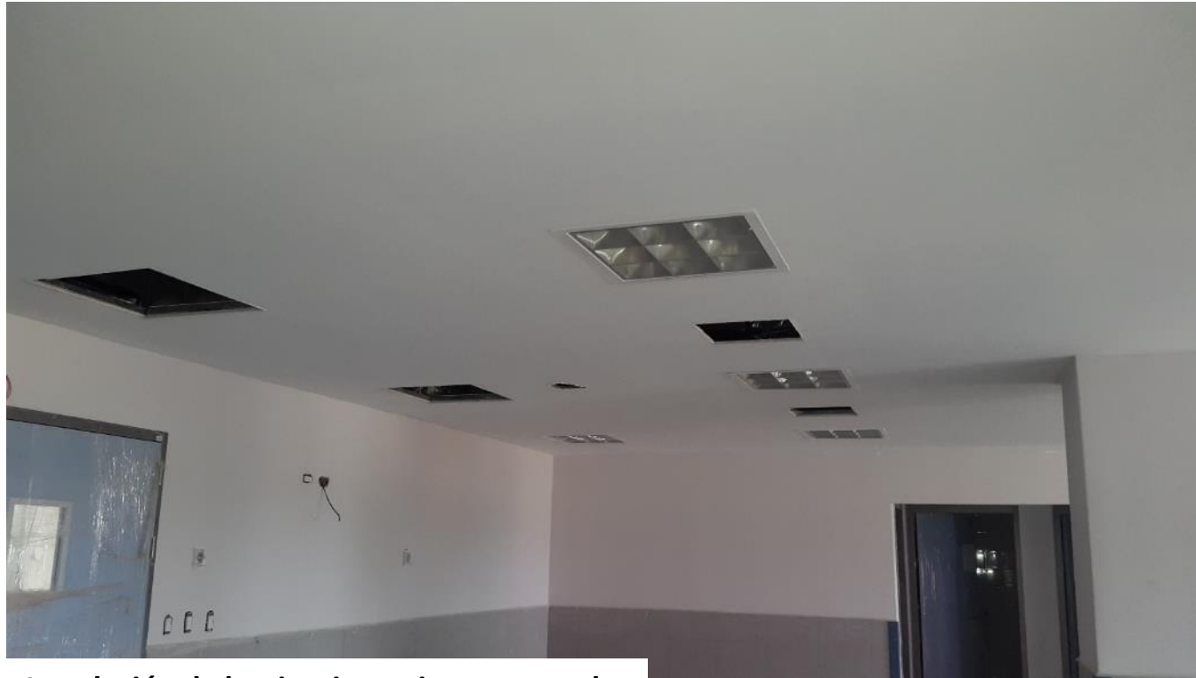
Instalación de luminarias y pintura en techo
