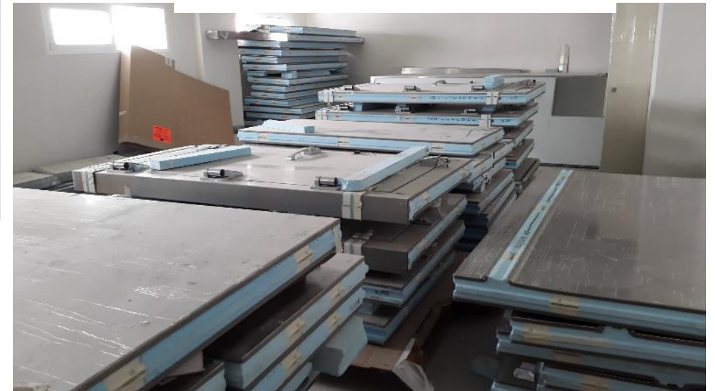
Instalación de cabinas de cuartos fríos
