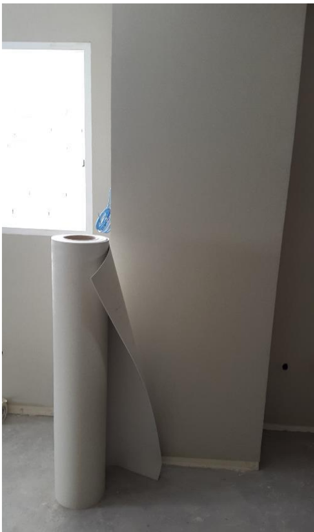
Instalación de caucho en paredes
