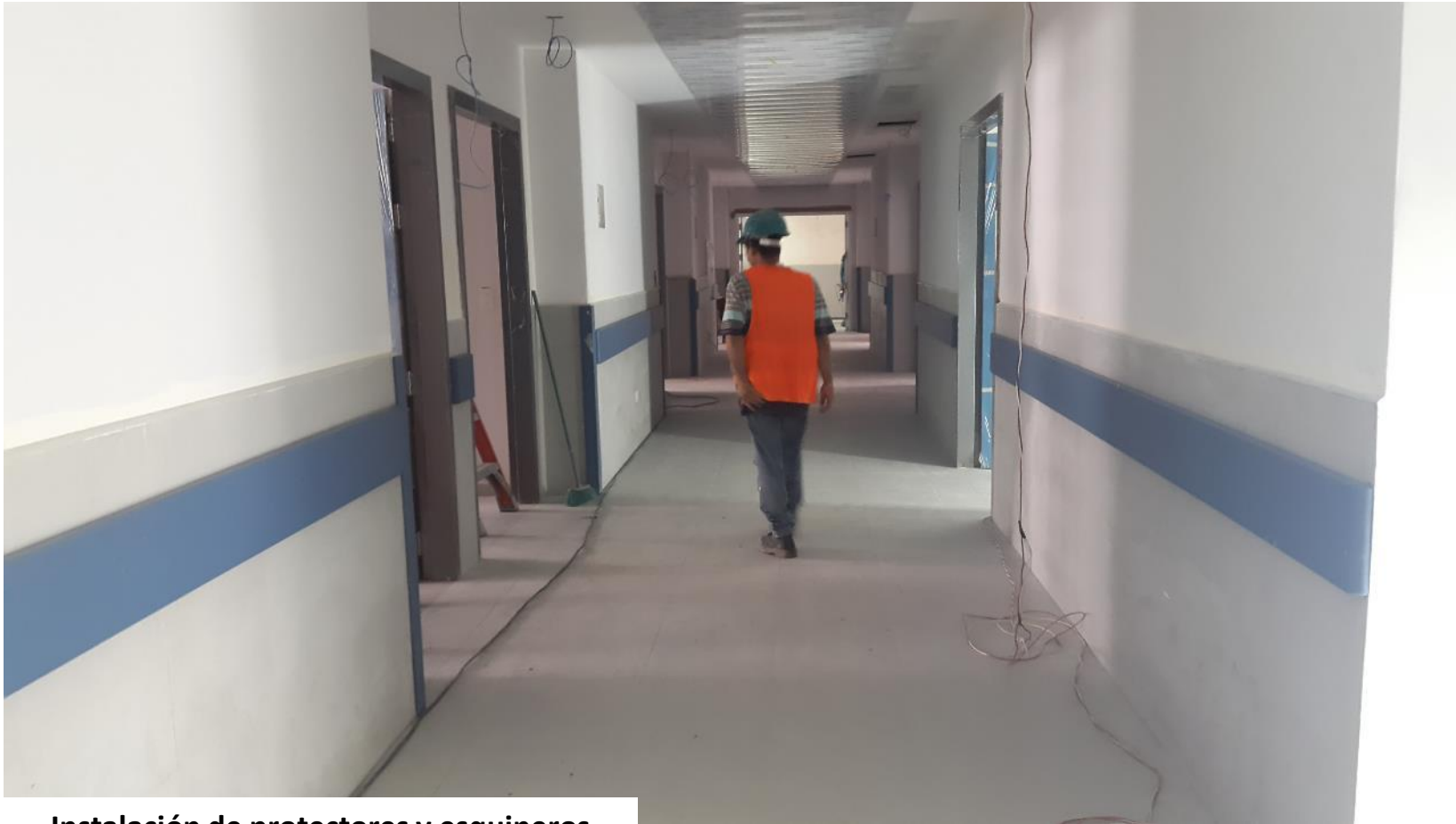
Instalación de protectores y esquineros
