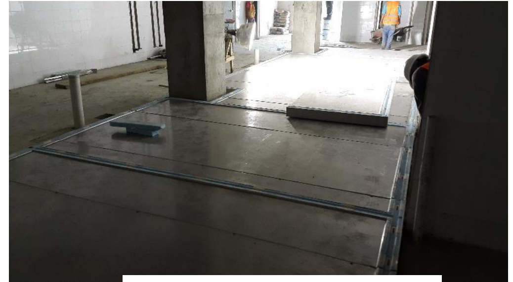
Instalación de cabinas de cuartos fríos
