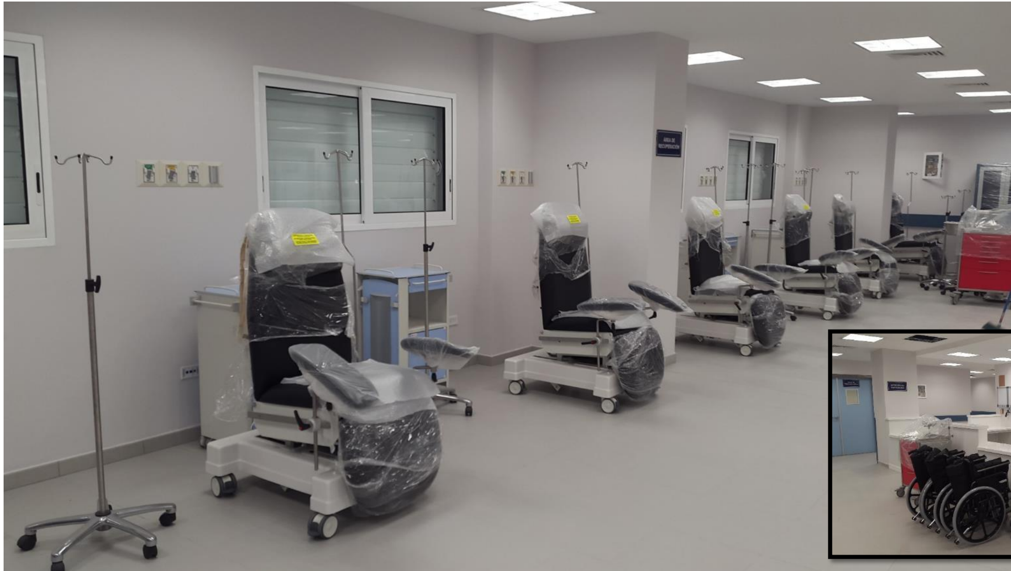
Equipamiento en área de recuperación
