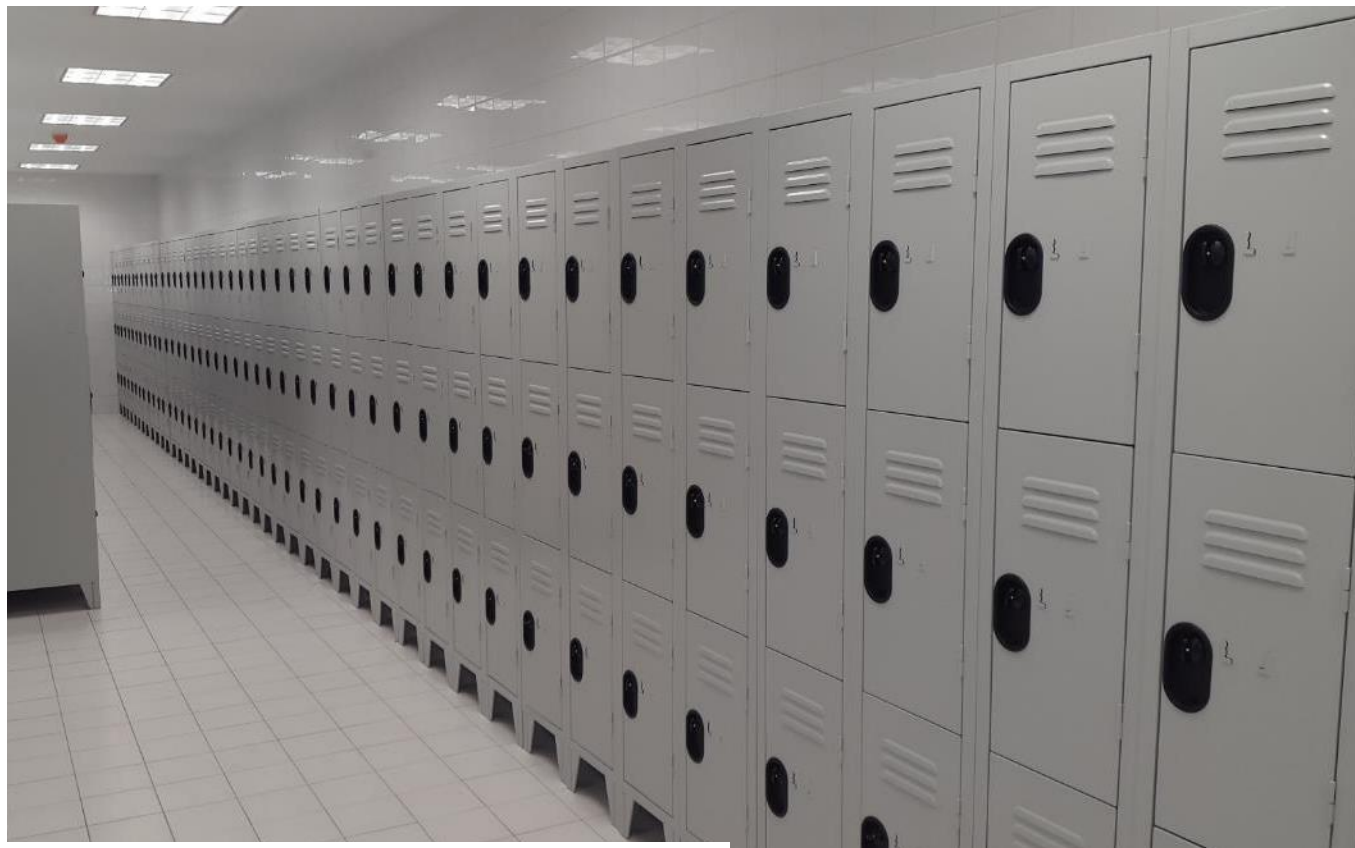
Colocación de muebles de oficinas y baños
