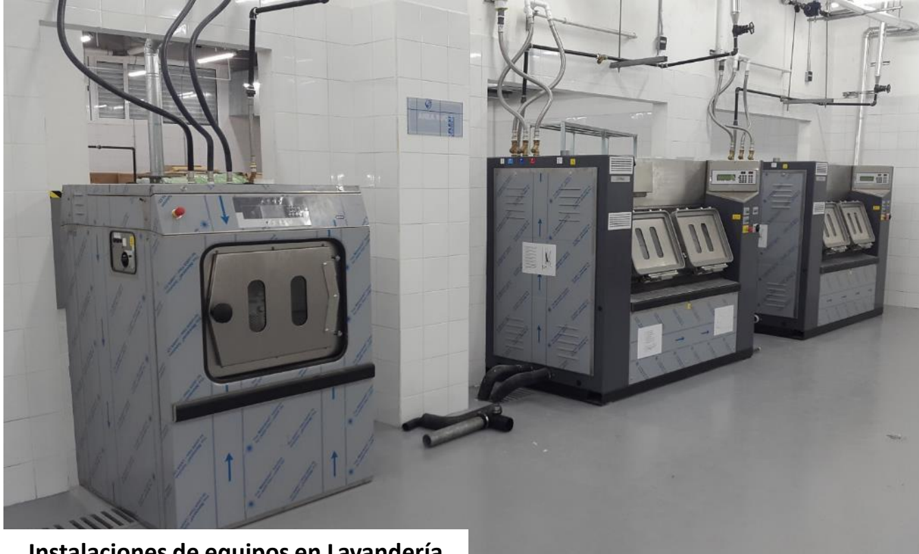
Instalaciones de equipos en Lavandería
