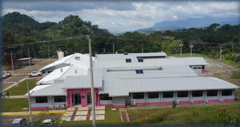
Hospital primario de El Cuá / Jinotega
