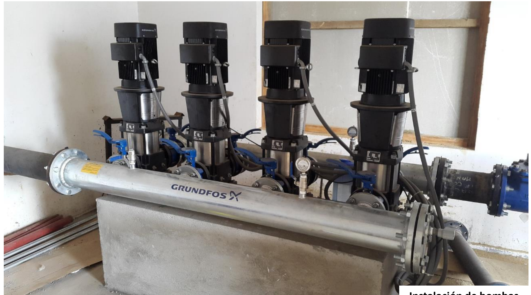
Instalación de bombas
