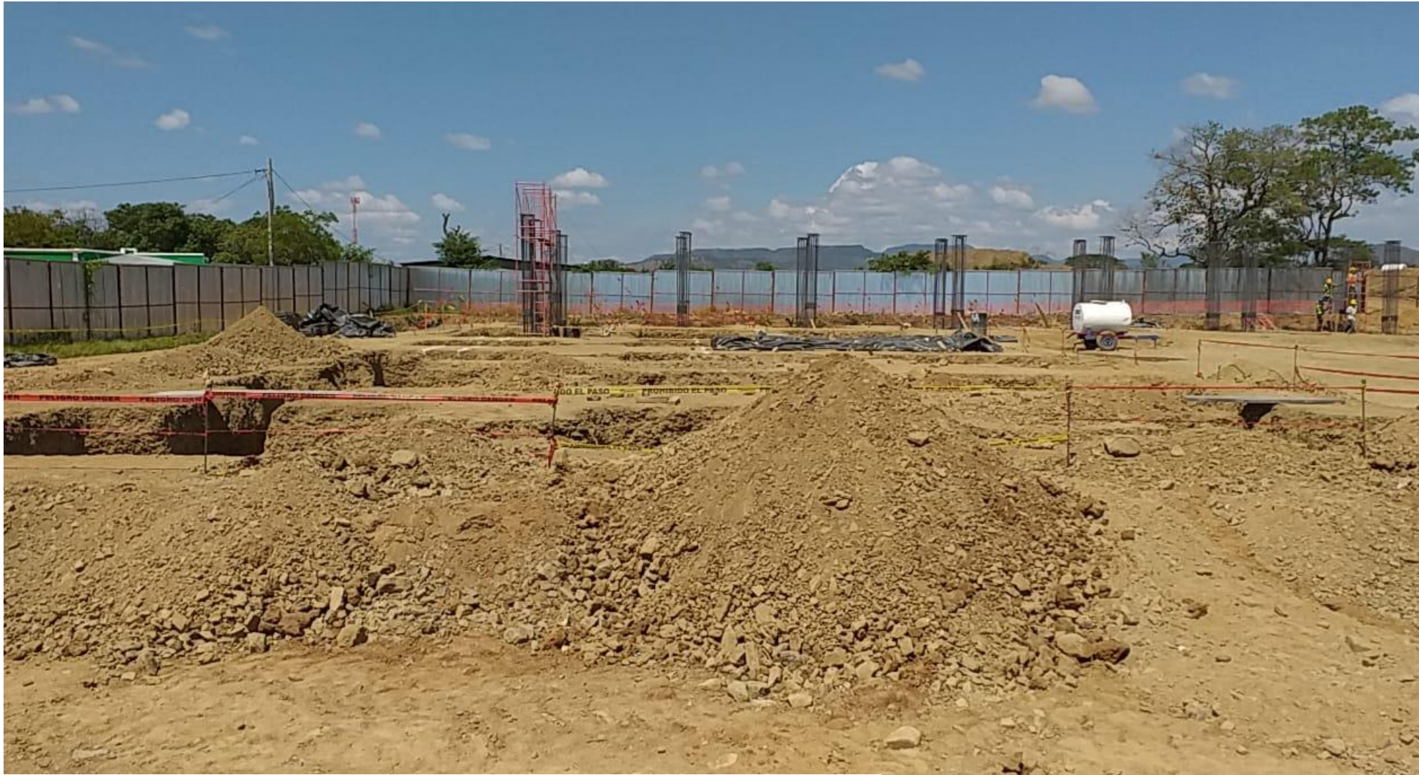
Excavaciones en Edificio G.
