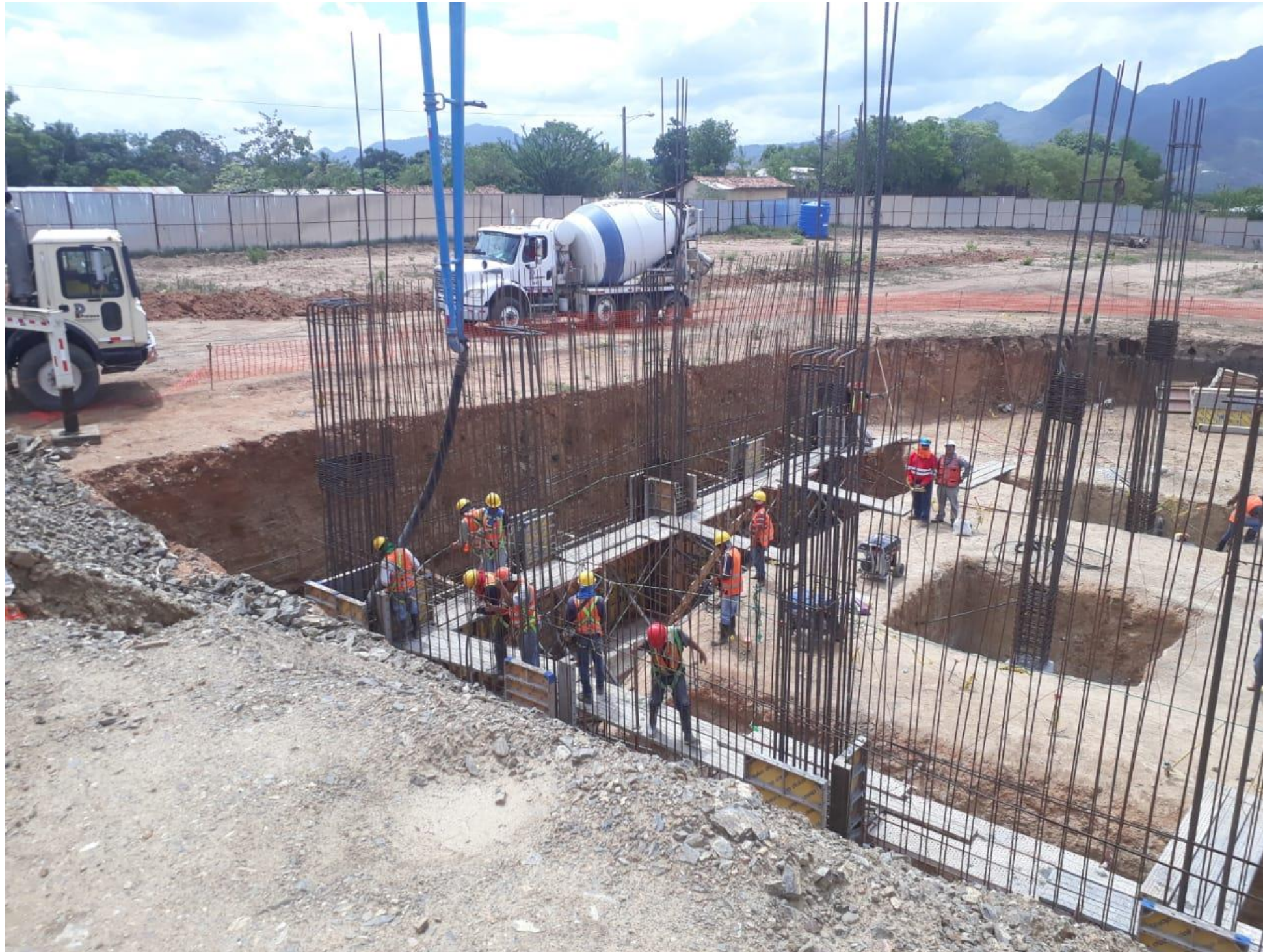
Colado en muro de contención en Edificio D.
