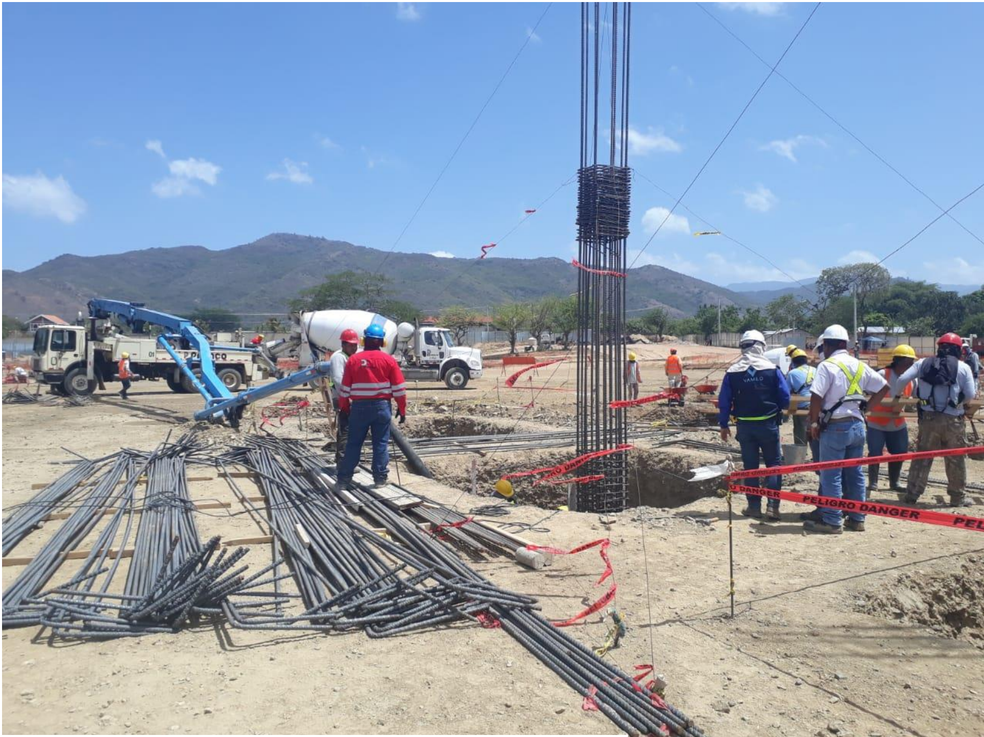
Armado de zapatas en Edificio E.
