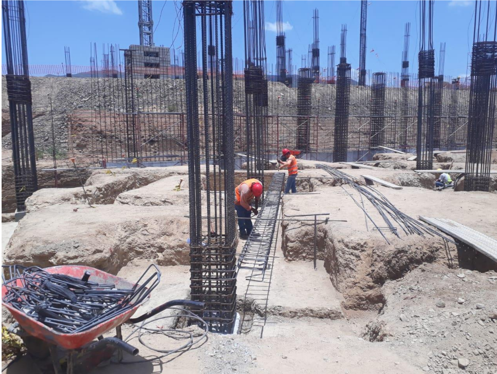
Armado de Solera de fundaciones en Edificio D.
