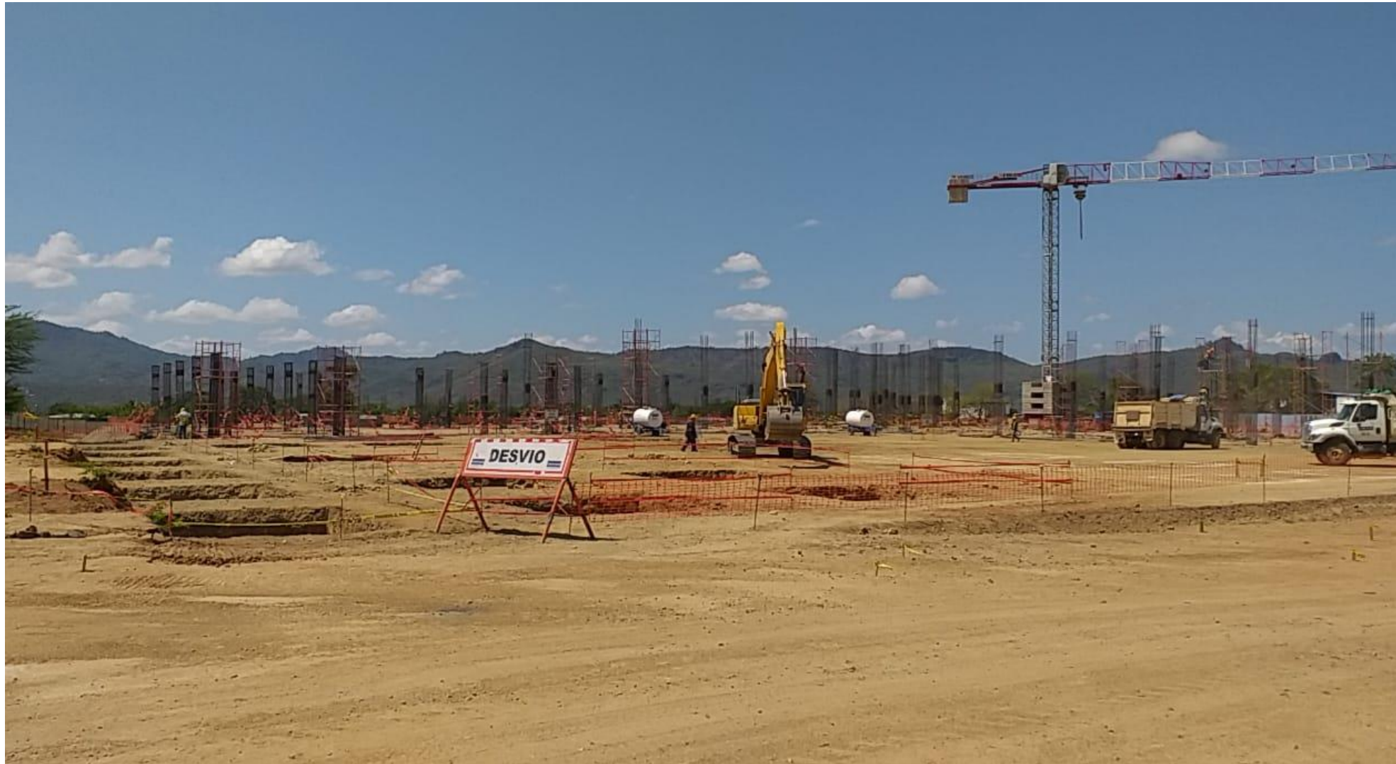
Excavaciones en Edificio F.
