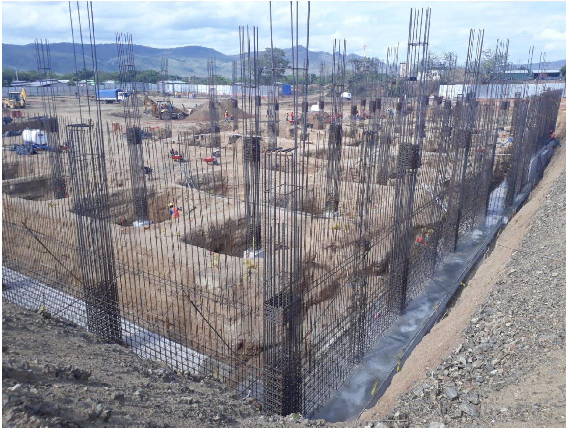
Vista general en Sótano.
