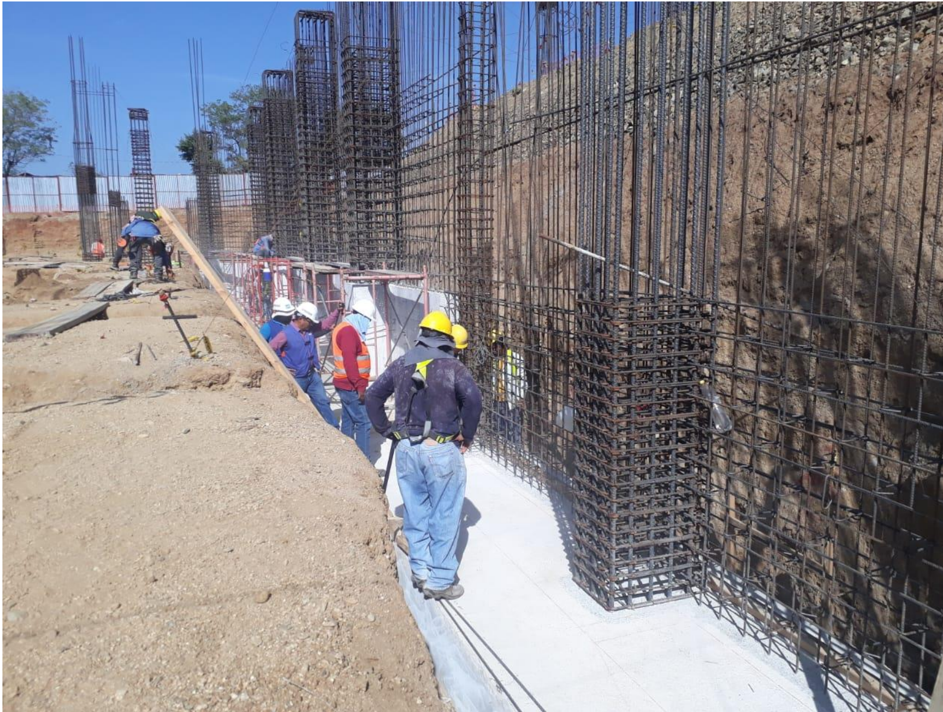
Vista 1 Zapata corrida y armado en muro de contención.
