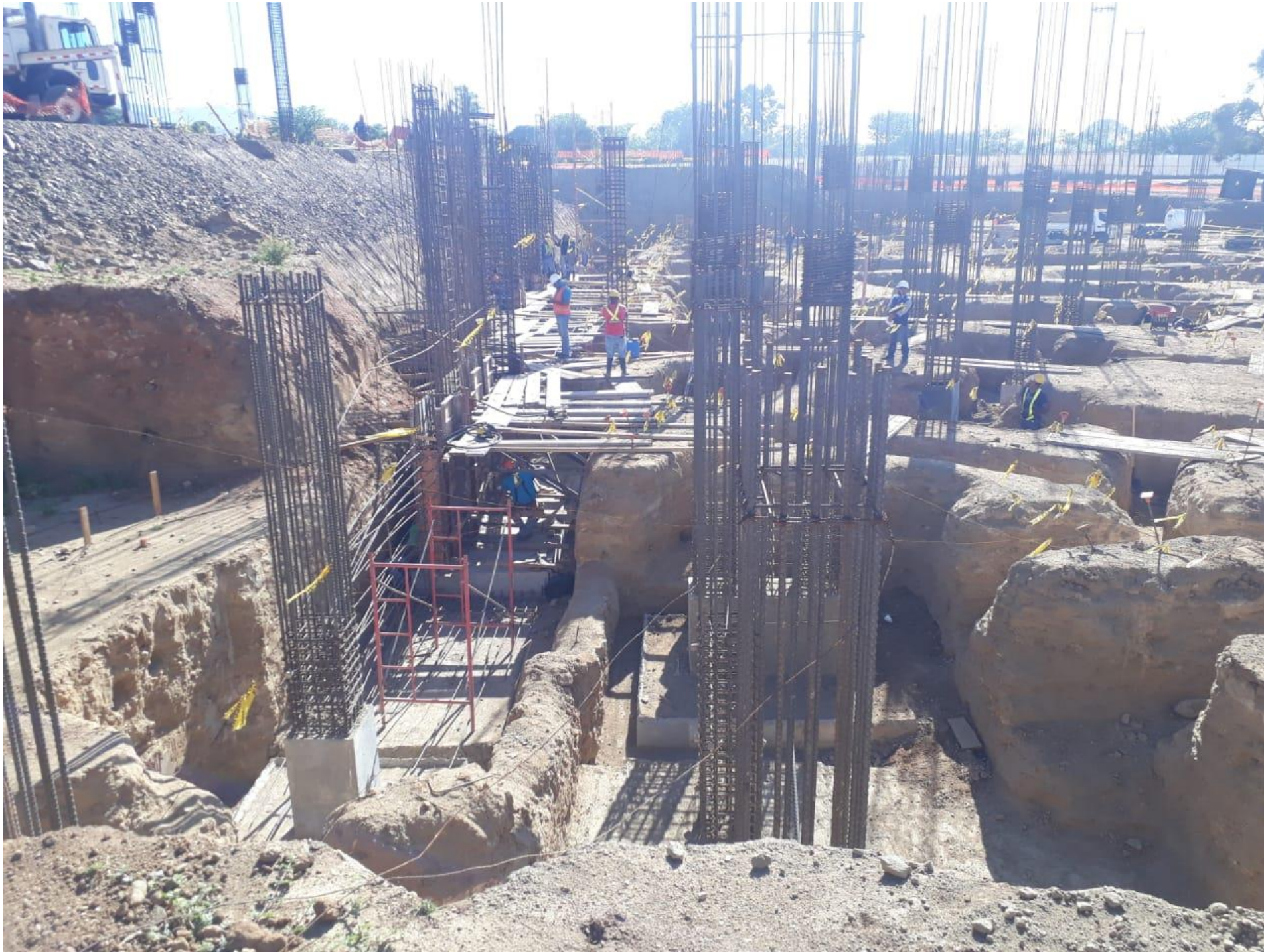
Armado en Edificio D, nivel sótano.
