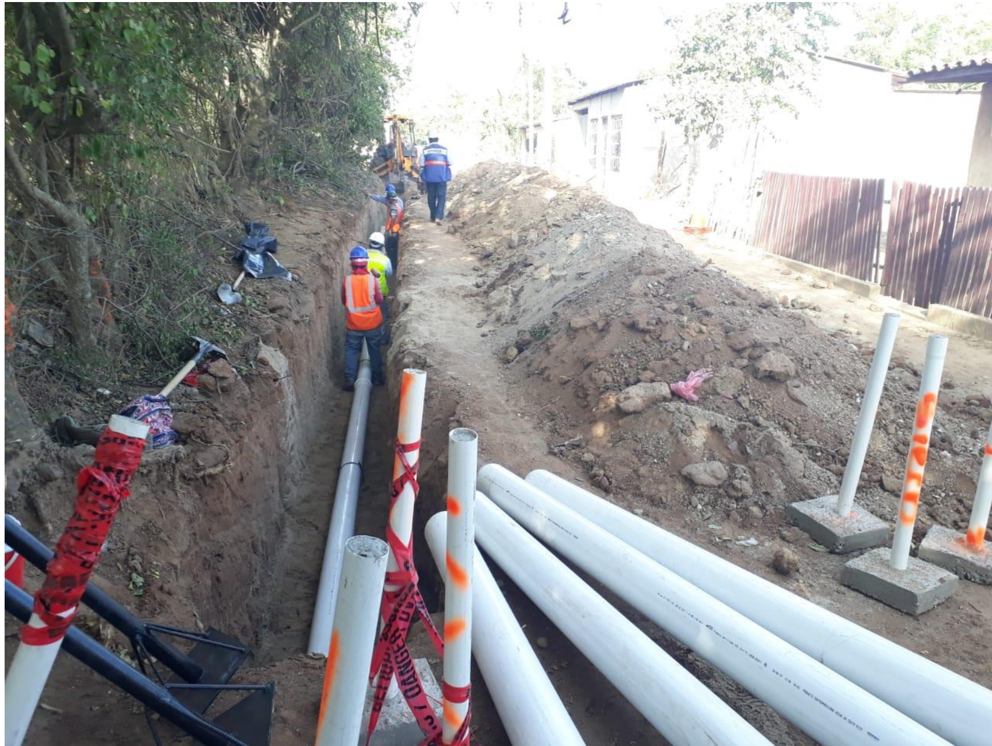
Instalación de red de agua potable.
