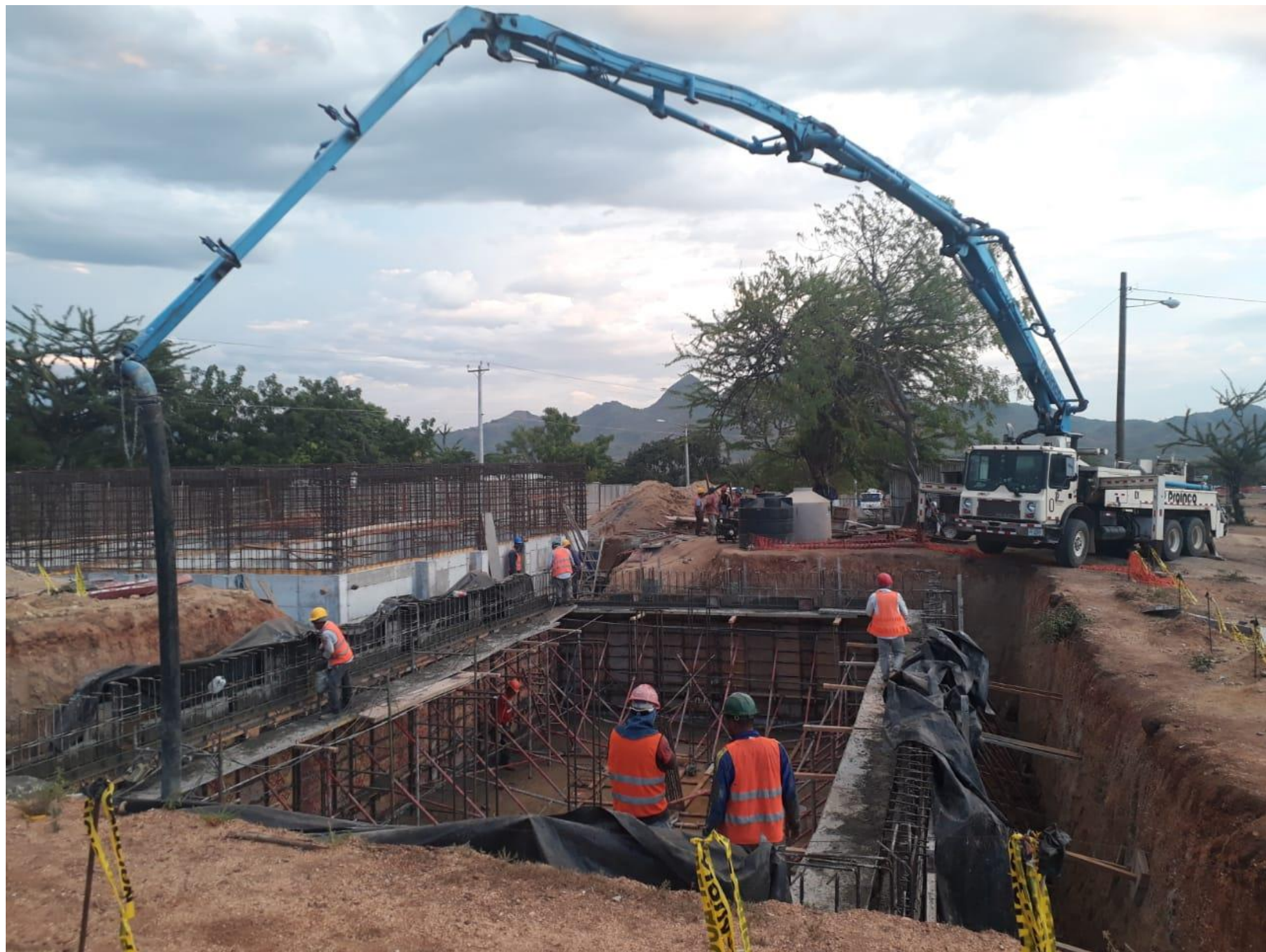
Colado de Cisterna contra Incendios.
