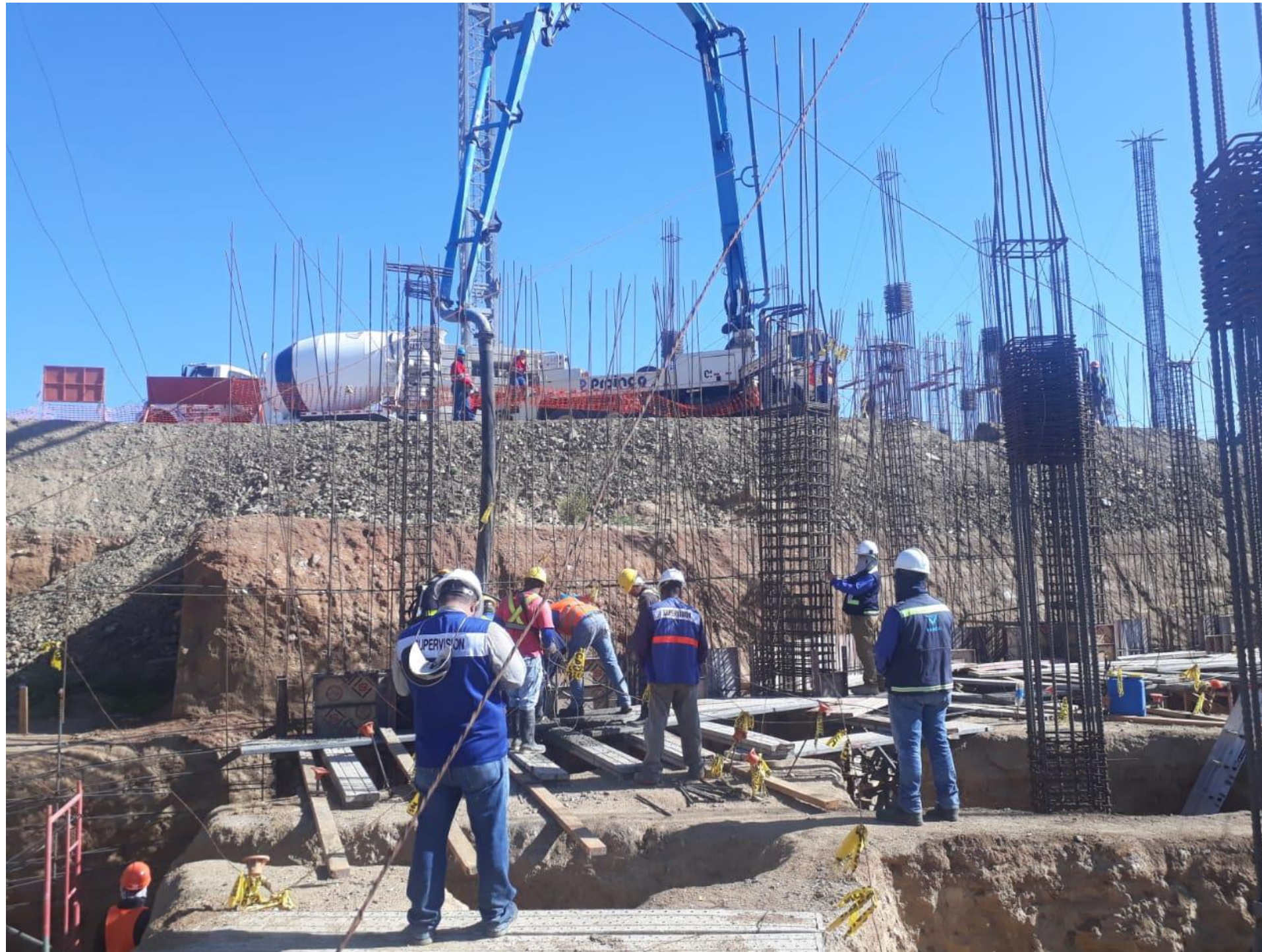
Colado en muro de contención. Edificio A.
