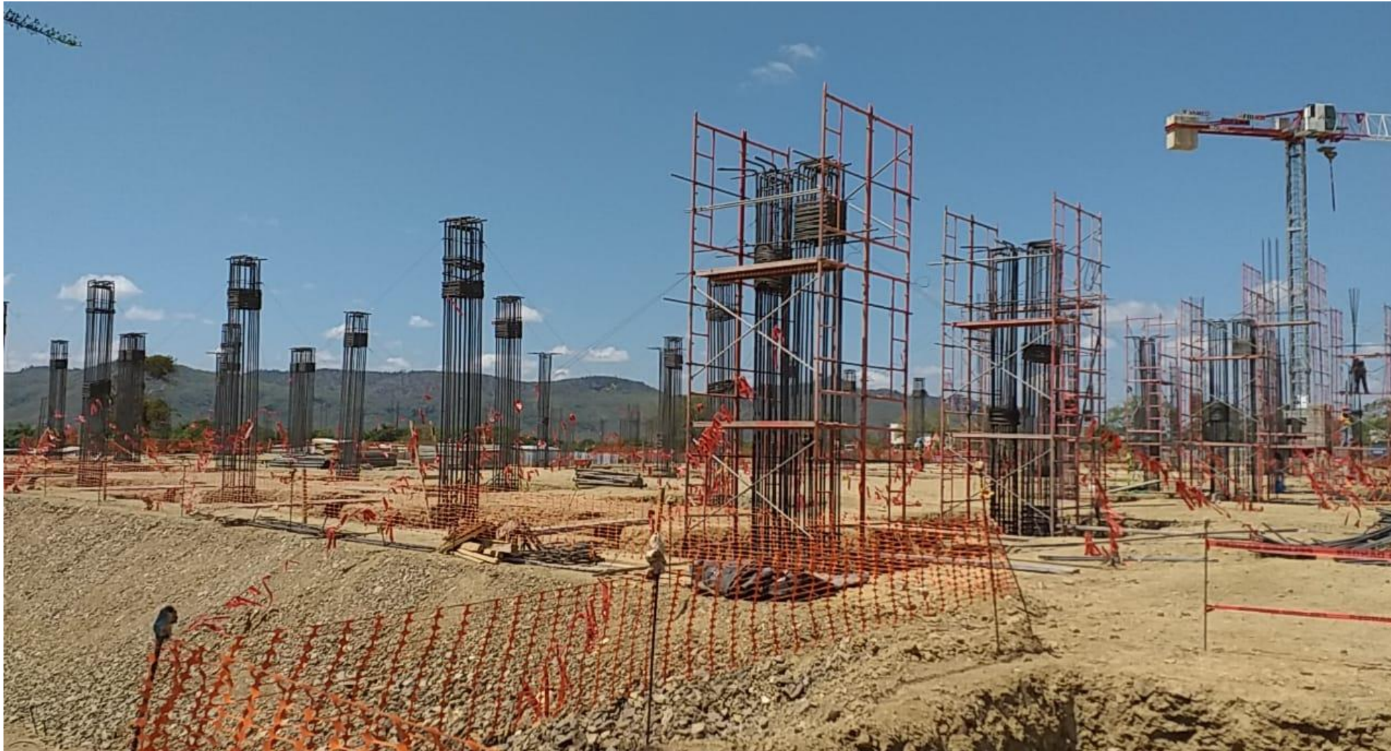
Armado de columnas en Edificio D.
