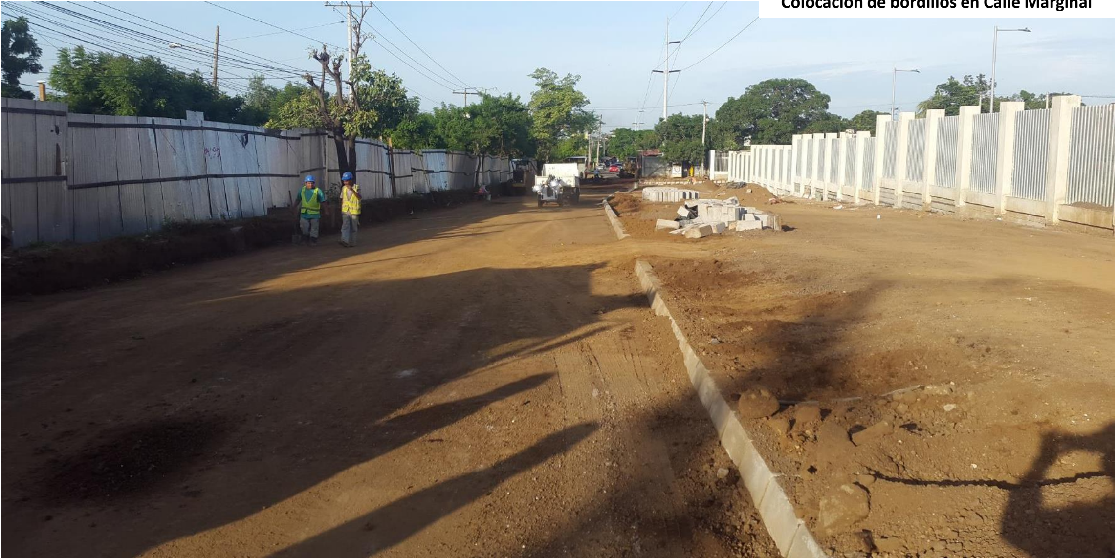
Colocación de bordillos en Calle Marginal
