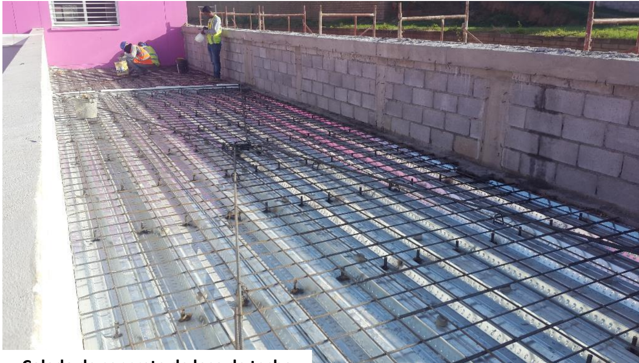
Colado de concreto de losa de techo
