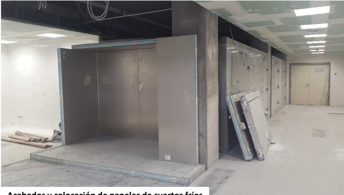
Acabados y colocación de paneles de cuartos fríos
