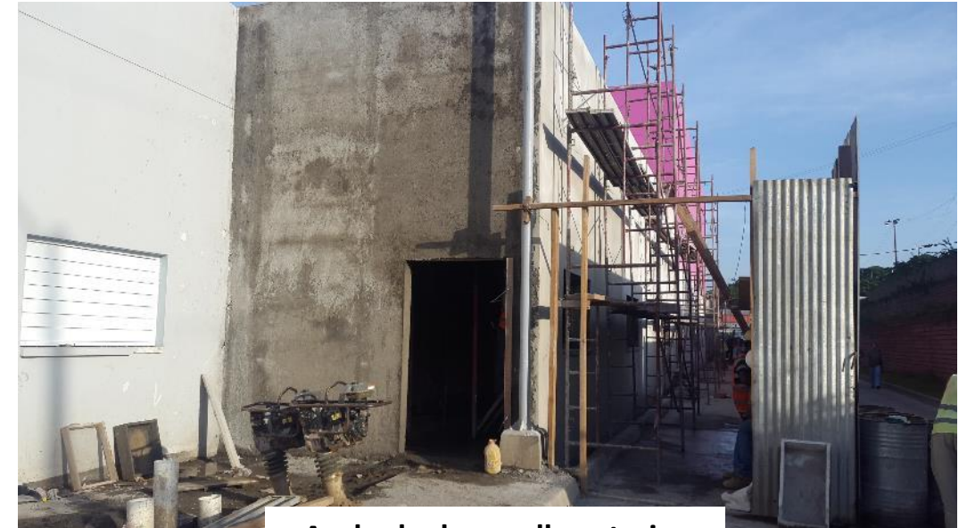
Acabado de repello exterior
