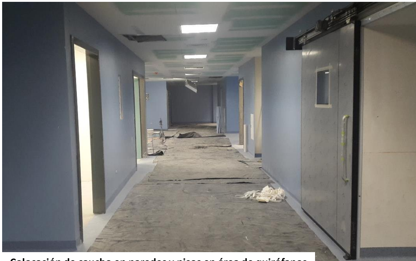
Colocación de caucho en paredes y pisos en área de quirófanos
