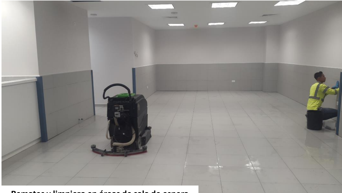
Remates y limpieza en áreas de sala de espera
