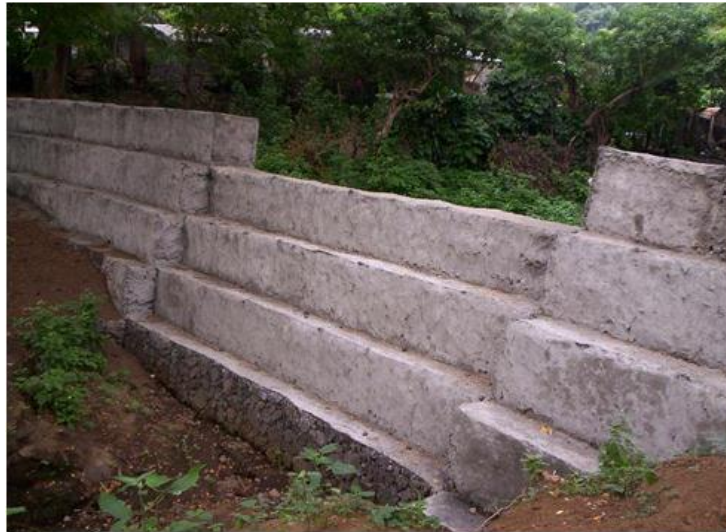
Figura 6.a. Ejemplo de dissipador de energía de las corrientes de agua. (Fuente POSAF-MARENA)
