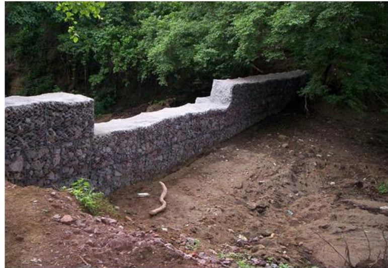
Figura 6.b. Ejemplo de sistemas de retención de sedimentos. (Fuente POSAF-MARENA)
