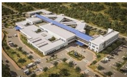
Das im Bau befindliche Departement-Krankenhaus von Nueva Segovia
