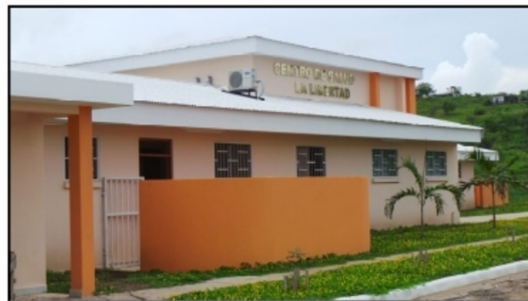
Centro de Salud en construcción (Mateare, Managua)
