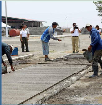
Construcción y equipamiento del Complejo Productivo y área de atención y trámites en el complejo Tipitapa
