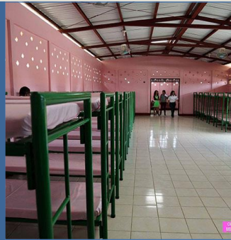
Construcción de 28 nuevos pabellones en los penales del país.
