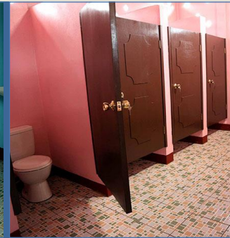
Rehabilitación de la red hidrosanitaria en los penales de Matagalpa, Tipitapa, Juigalpa, Granada y Estelí.
